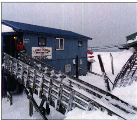
In diesem Gebäude ist der Waschraum mit Waschmaschine und Dusche untergebracht.
