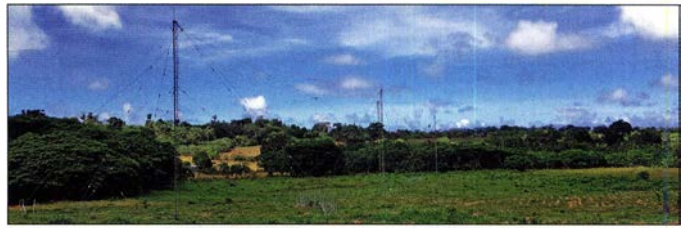
Als Sendeantenne für Kurzwelle verwendet Radio Vanuatu wie bisher diesen Breitbanddipol.
