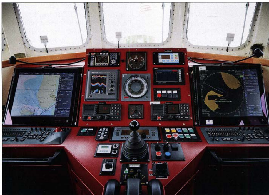
Brücke des Seenotkreuzers Pidder Lüng : außen die beiden ECDIS-Einheiten; Mitte von oben links: Peilgerät, Ruderlageanzeige, SARCUM, Echolot, Kreiselkompass, Zentraleinheit für Alarmer und Überwachung diverser Bordanlagen, VHF-Funkgeräte
