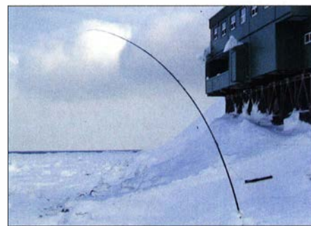
Der Antennenmast bog sich im ständigen Wind.
